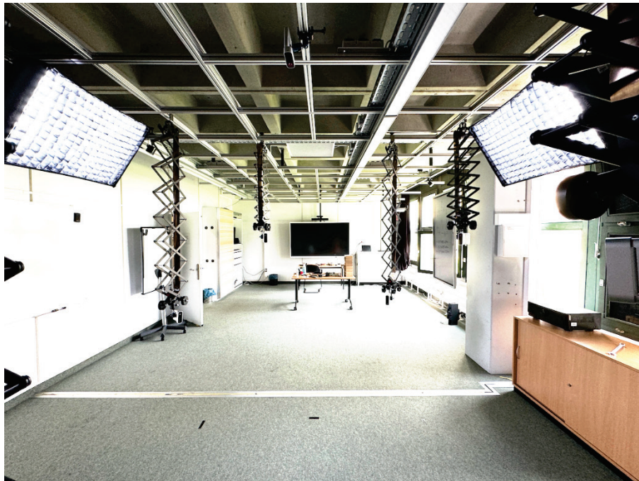
Abb. 5: Deckentraverse und Doppelscheren an denen die Kameras von der Decke abgehängt werden.
